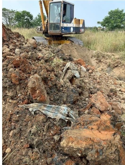
現場開挖情形
