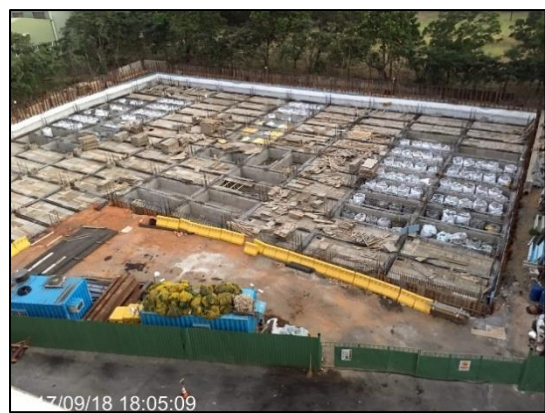
廢棄物回填地下停車場下筏式基礎
