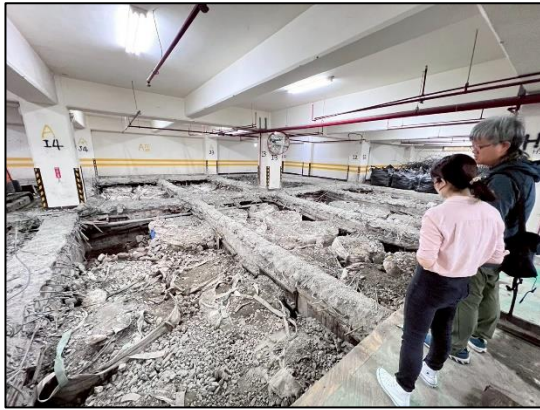
廢棄物回填地下停車場下筏式基礎
