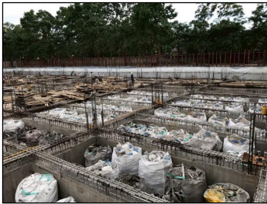
廢棄物回填地下停車場下筏式基礎
