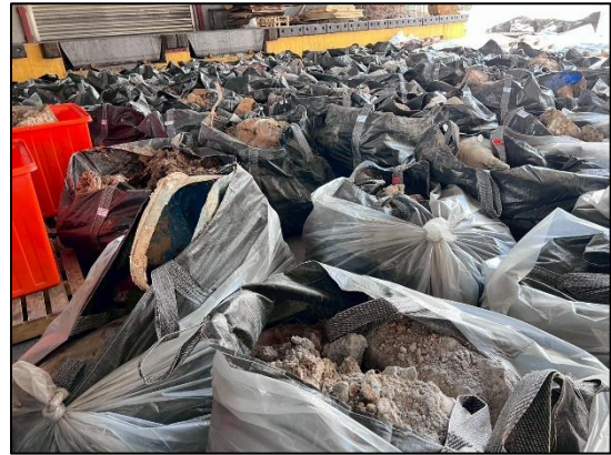
廢棄物回填地下停車場下筏式基礎
